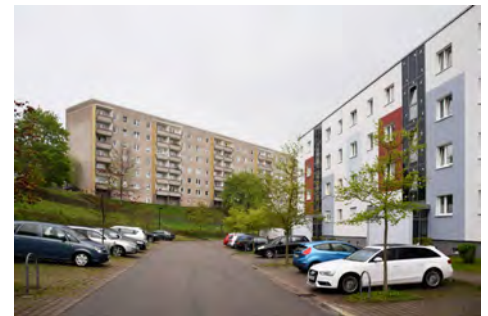
Sanierte Blöcke im DDR-Wohnbaugebiet „Porlitzer Höhe“ in Ilmenau
