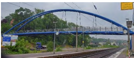
Bahnübergang in Heilbad Heiligenstadt
