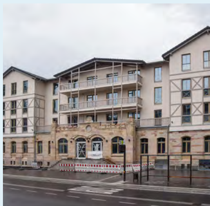
Umbau des Empfangsgebäudes
