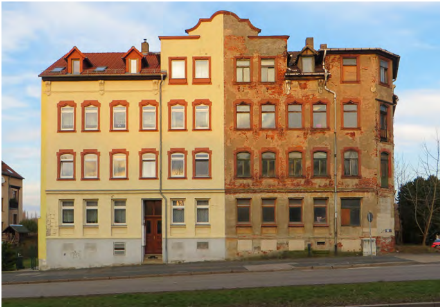
Altenburg: saniert neben unsaniert
