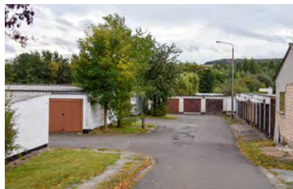
Zum Abriss freigegebener Garagenhof für Gartenstadtbebauung in Leinefelde-Worbis
