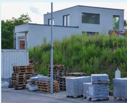
LEINEFELDE-WORBIS: Einfamilienhaus auf Rückbaustandort
