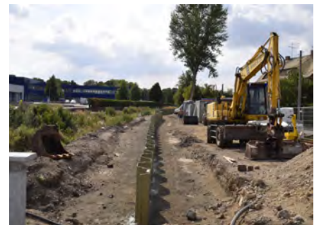
Bau einer Hochwasserschutzmaßnahme in Meuselwitz
