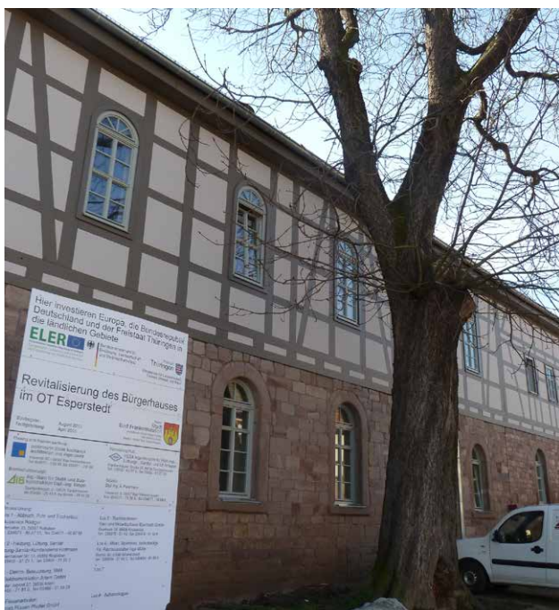
Revitalisierung eines Bürgerhauses in Bad Frankenhausen
