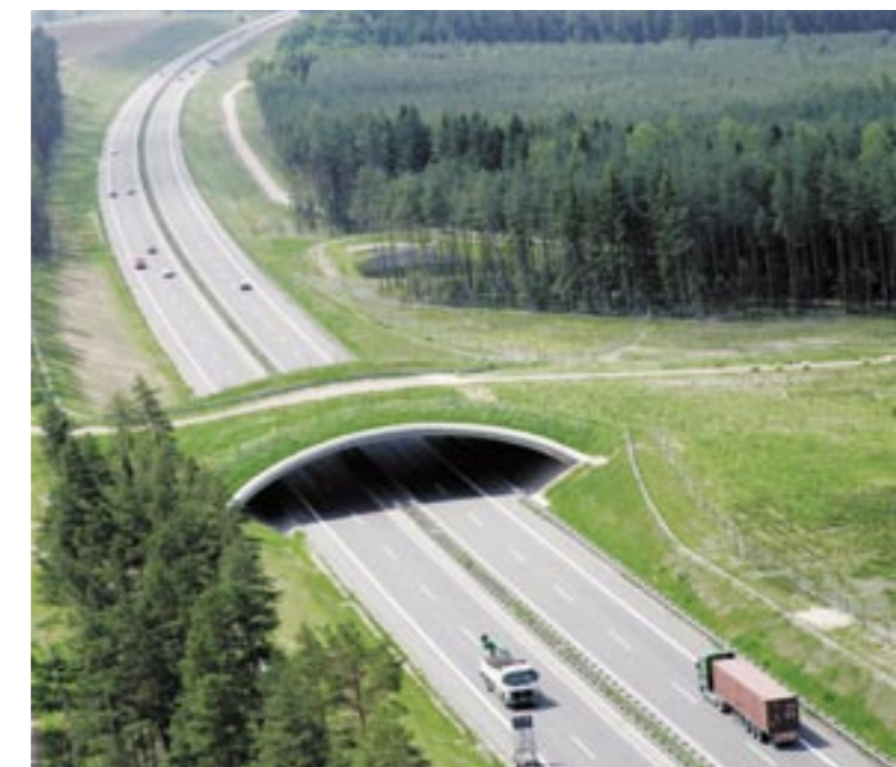
Un pont pour préserver l'habitat des animaux sur l'A71
